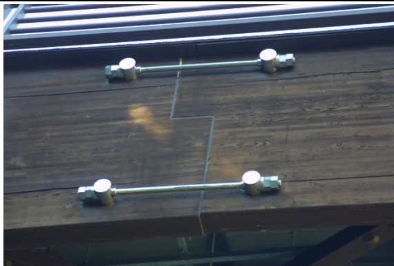
主桁継ぎ手部にわれが生じている。進行に注意する必要がある。
