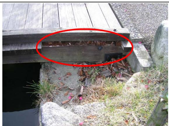
地覆下の床版が腐朽し、張出部が折れてい
