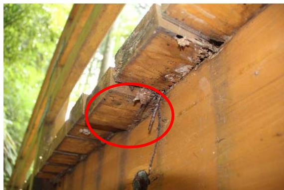
主桁材と床版材の接触面が腐朽し、床版材が沈んでいる。
