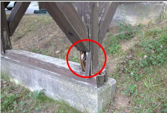
斜材取り付け箇所の下部が腐朽している。
