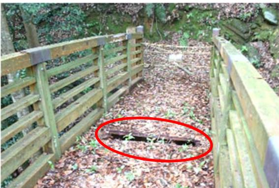
床版材が折損・脱落している。
