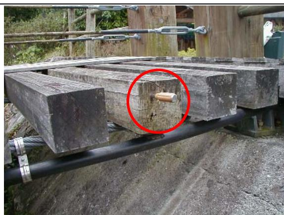
ドライバーが簡単に突き刺さるほどにボンゴシ材の内部が腐朽している。
