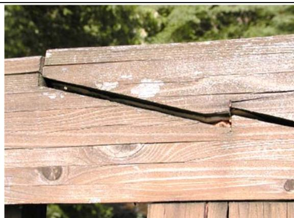
接合部分の隙間から蟻土が見える。
