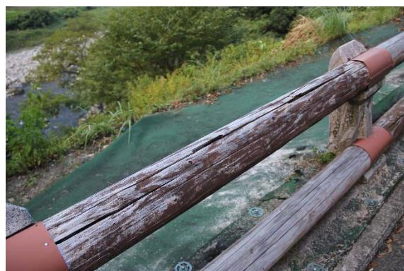
割れているだけに見えるが内部はほぼ腐朽している。
