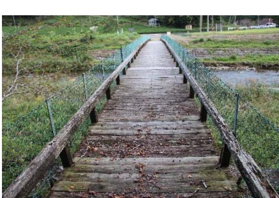
落ち葉や木の実の堆積は腐朽を促進しやすい。手前の部分には落葉樹がある。
