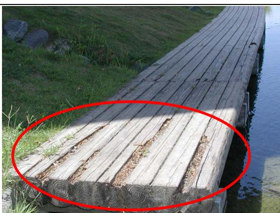
道路橋の下にあるため、雨がかかる部分の辺材部（丸太周囲の淡色部分）が腐朽している。
