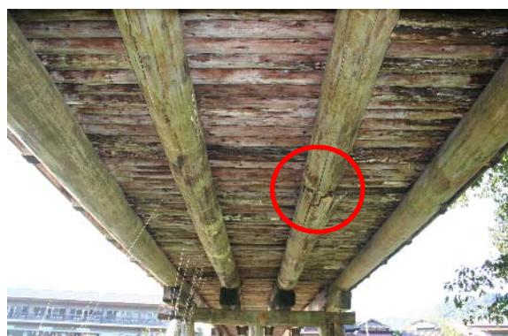
桁が曲げ破壊している。
