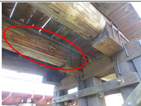
腐朽は辺材部（丸太周囲の淡色部分）に止まっている。それを確認する必要がある。
