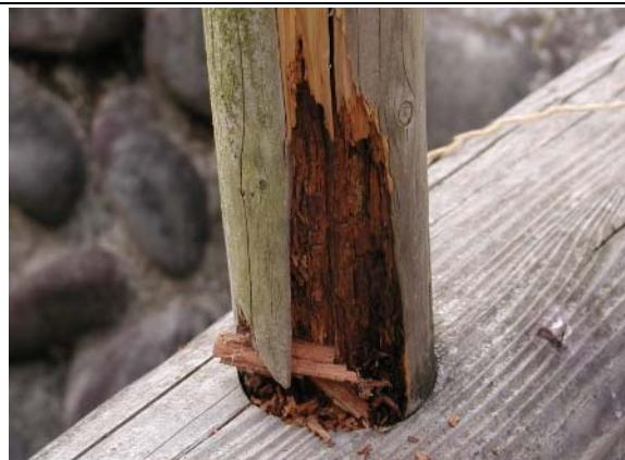
高欄柱の基部。水が溜まりやすい下縁部が腐朽している。
