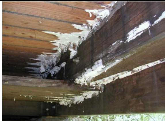
床版裏面の木材腐朽菌。これが見られる場合、部材内部の腐朽が疑われる。
