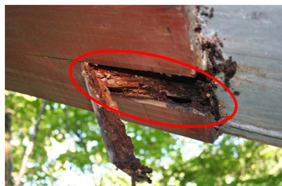
鋼材との接合部の腐朽の例
