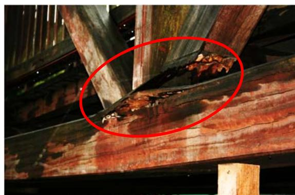
トラス格点部が腐朽により破壊している。
